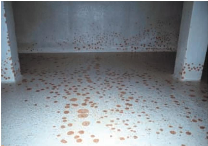
*Abb. 1: Fleckige Korrosion ungeeigneter Mörtelauskleidungen in Trinkwasserbehältern*
